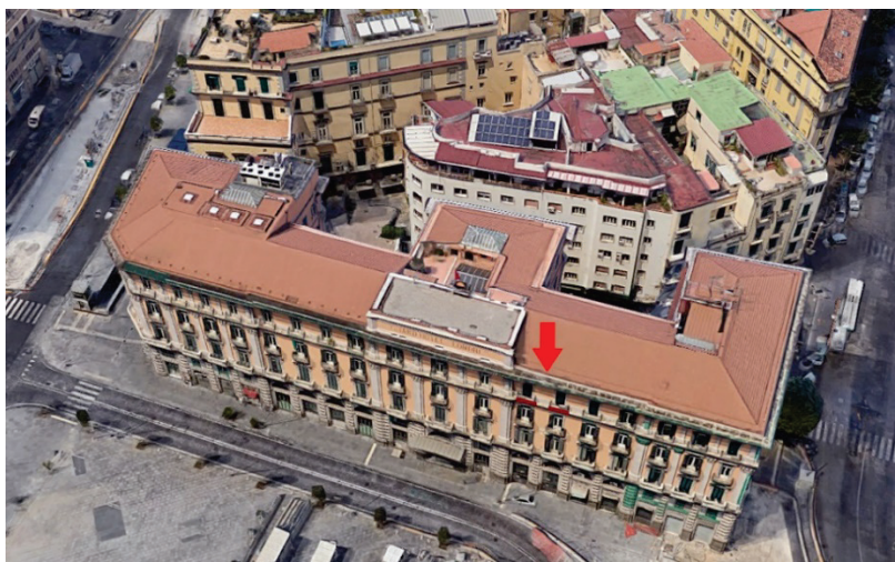
I balconi della suite al 4° piano dove soggiornò Churchill identificati dall'avv. Marotta
